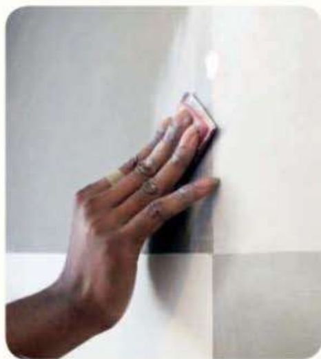
3. Setelah kering, ampelas kembali bagian dinding yang sudah diplamur agar permukaan kembali rata.
