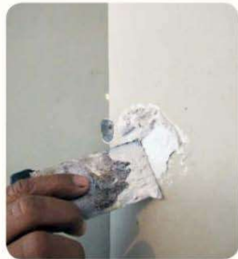
2. Aplikasikan plamur untuk mengisi lubang dinding.
