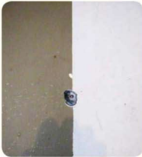
1. Kerok dinding yang rusak dengan kape, kemudian ampelas.
